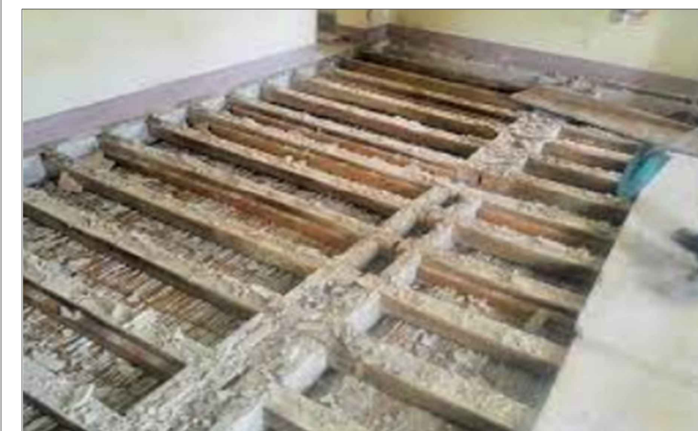
Immagine extradorsale del solaio di piano a doppia orditura presente al primo piano dell'edificio, locale 3;
